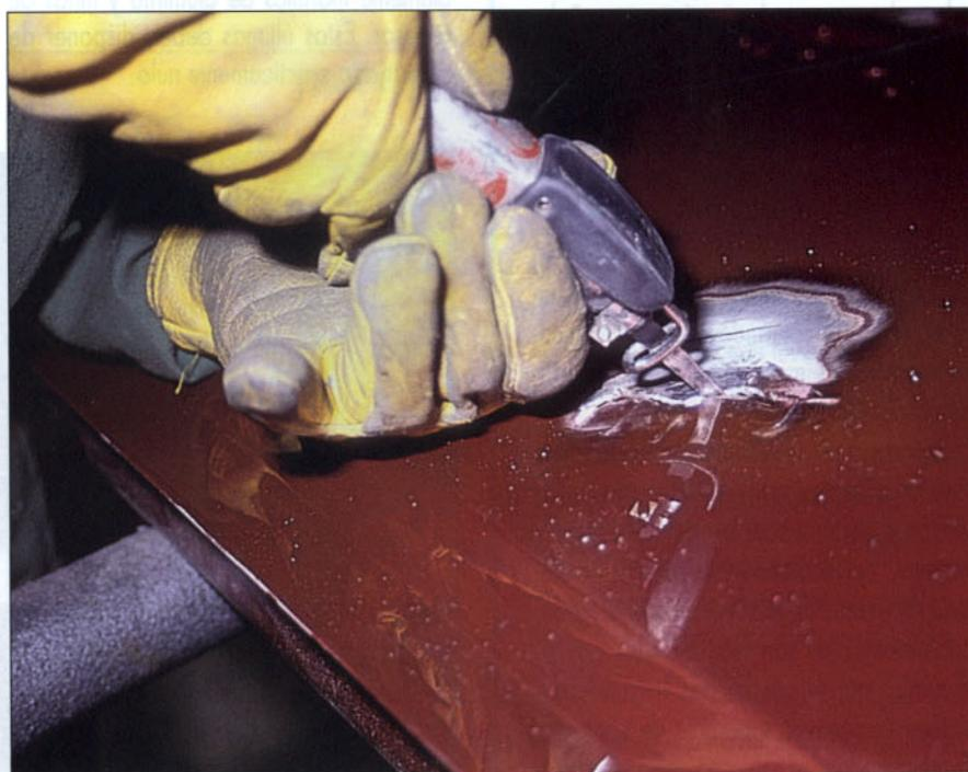
*Ajuste de los bordes en la reparación de una rotura.*
