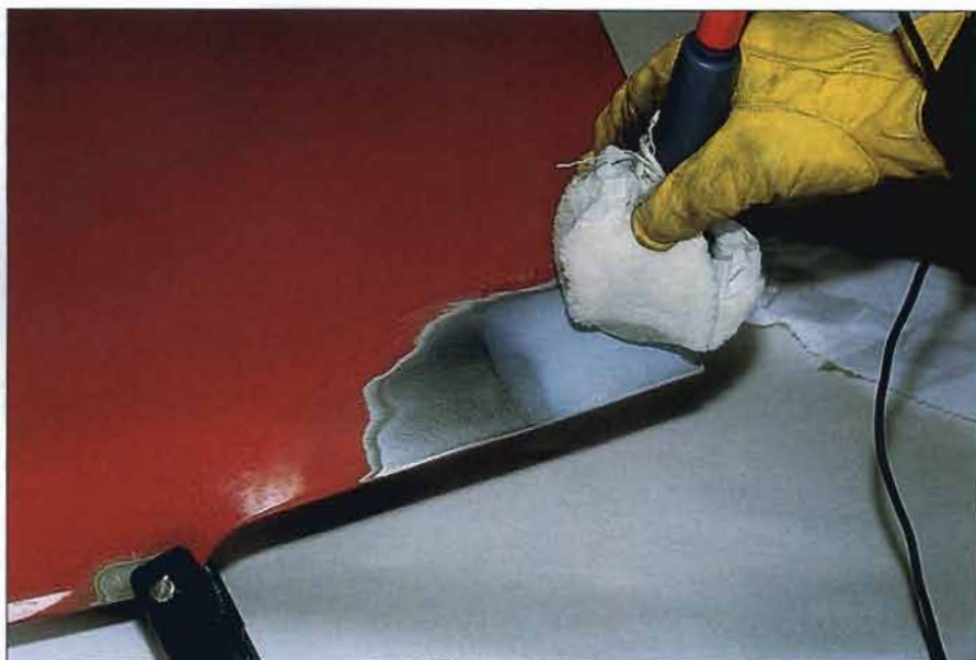
El taller puede volver a aplicar el revestimiento de cinc eliminado en la reparación.
