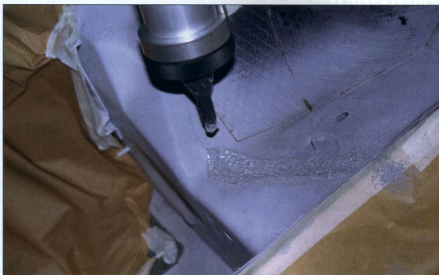
Aplicación de un sellado rugoso
