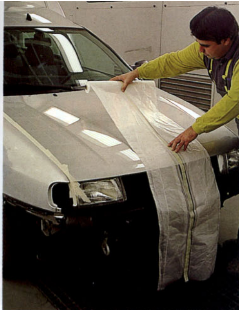
Desenrollado y pegado del plástico de enmascarado
