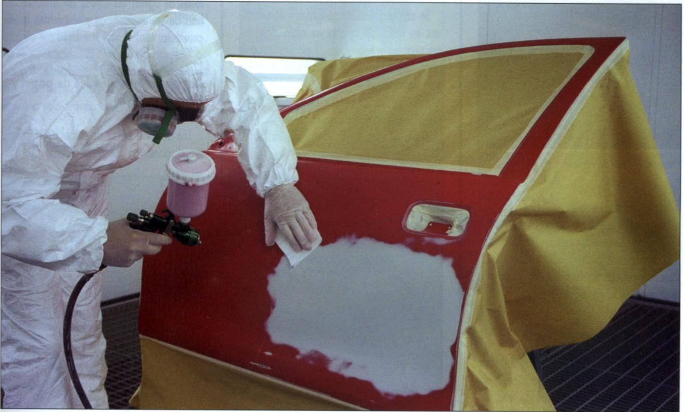
**L**a aplicación de productos como imprimaciones, pinturas y barnices mediante pistolas aerográficas genera una niebla de pulverizado que, en parte, se depositará en zonas adyacentes. Por ello, es necesario recurrir a los productos y útiles de enmascarado, que evitarán el costoso trabajo de eliminación de dichos pulverizados.
