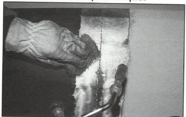
3.4. Extender las gotas de estaño-plomo con un estropajo de aluminio para formar el baño o película de anclaje para el relleno posterior
