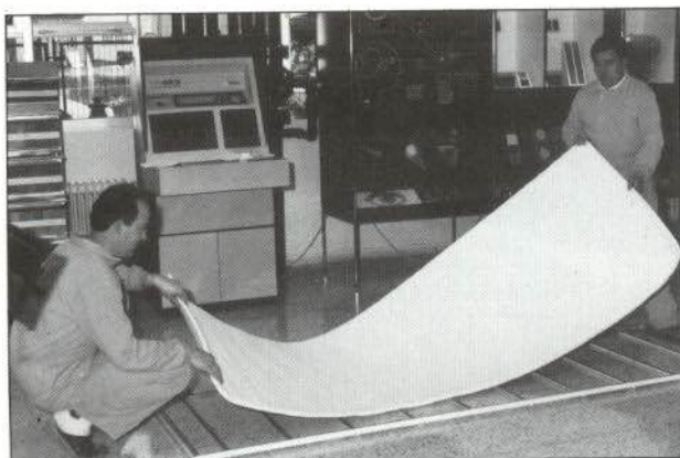
Figuras 3a y 3b.—Sustitución de filtros de techo.
