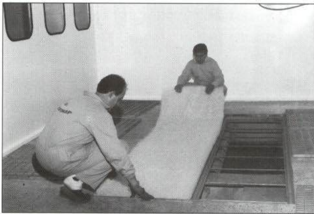
Figuras 4a y 4b.-Sustitución de filtros de suelo.
