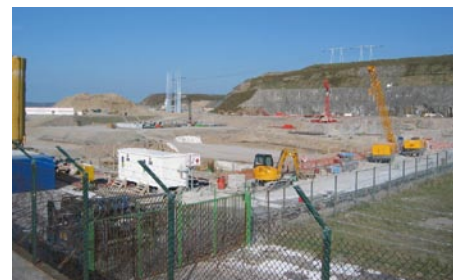
Trabajos de construcción en la central nuclear de Flamanville (Francia)
