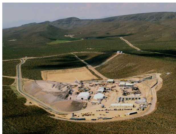
Vista aérea de las entradas norte y sur del repositorio de Yucca Mountain
