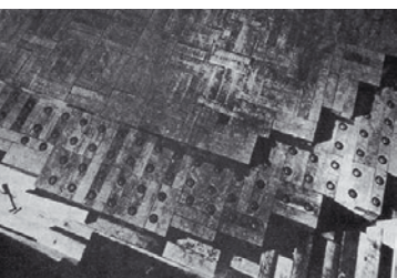
Bloques de grafito con cilindros de uranio insertados
