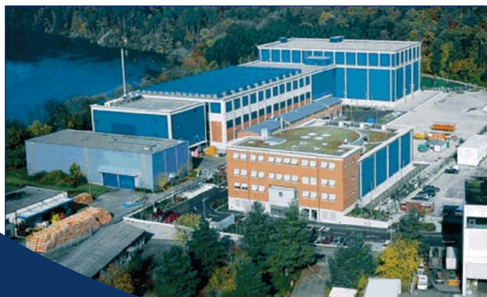
Almacén de combustible gastado de Zwilag
