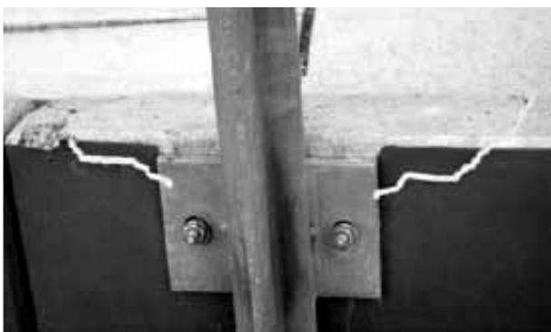
Figura 6. Rotura de anclaje. Anclaje no adecuado al esfuerzo por efecto palanca
