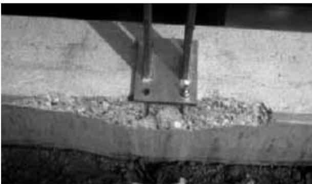
Figura 5. Rotura de anclaje. Distancia mínima al margen de hormigón no respetada o par de apriete excesivo
