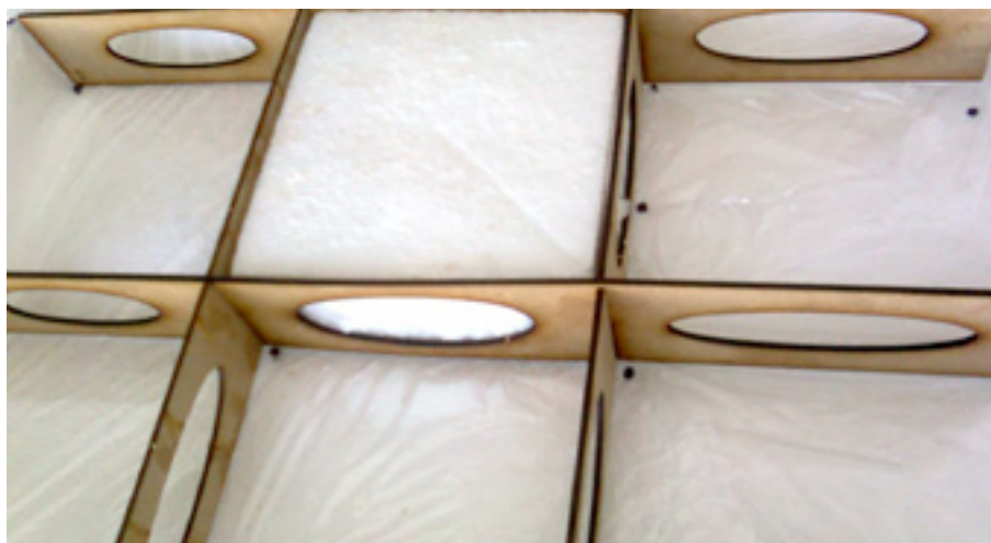
Figura 4.52. Molde protegido con plástico aislante y estructura de madera.
