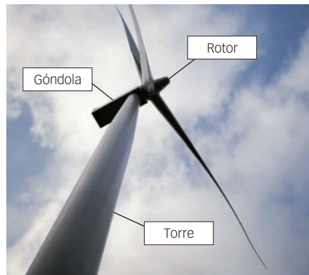
Figura 1. Componentes principales del aerogenerador.
