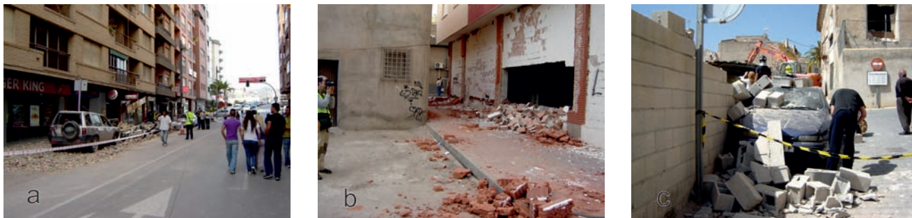
Figura 1. En el terremoto de Lorca de 2011, la caída de elementos no estructurales como cornisas, paños de fachadas o muros causó la mayoría de los daños materiales y víctimas. Este terremoto es un ejemplo de los daños que puede sufrir una ciudad española ante un evento sísmico de moderada magnitud.
