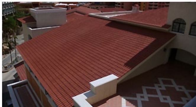
Falsas tejas (de hormigón) sin afectación.
