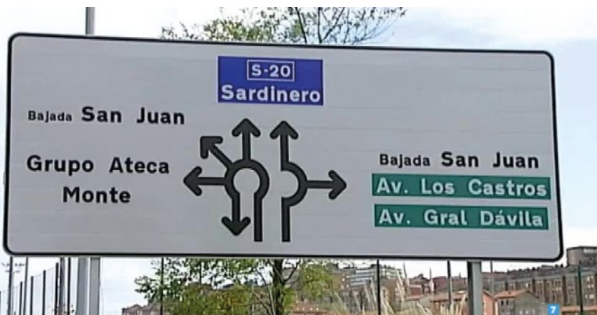
► Señalización de una turborrotonda
