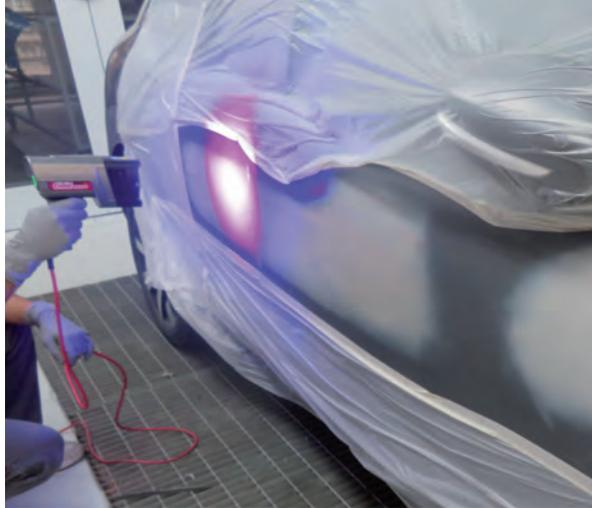
En la reparación **eficiente**, el vehículo no se ha movido aún de la zona de preparación. Sin embargo, en la **estándar** el vehículo ha de regresar a la zona de preparación para afrontar el lijado del aparejo.
