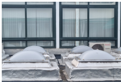
Imagen 2. Lucernarios de metacrilato en edificación destinada a oficinas. Fuente: INSST.
