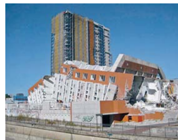
Figura 8. Edificio totalmente desplomado, en Concepción (Fuente: AIR)
