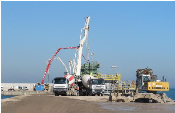
OBRAS DE ABRIGO PARA AMPLIACIÓN PUERTO VALENCIA
