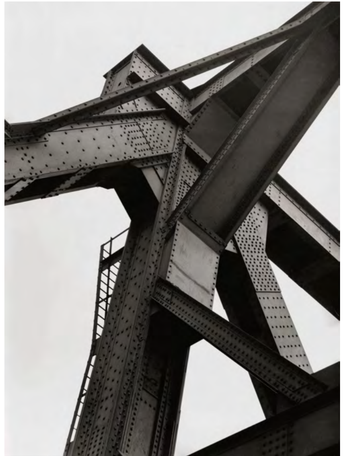
Albert Renger-Patzsch, Un nodo del puente de celosía de Duisburgo -Hochfeld [19] Ein Knotenpunkt der Fachwerkbrücke Duisburg-Hochfeld. © Albert Renger-Patzsch / Archiv Ann e Jürgen Wilde, Zülpich / VEGAP, Madrid 2017
