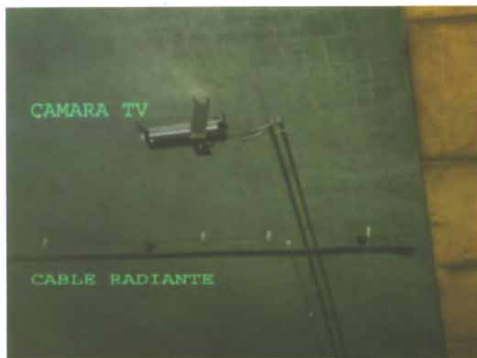
Techo del Túnel: cámara y cable radiantetico
