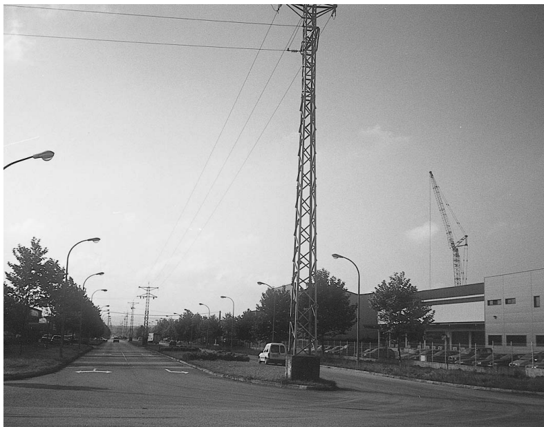
Pal elèctric sense protegir
