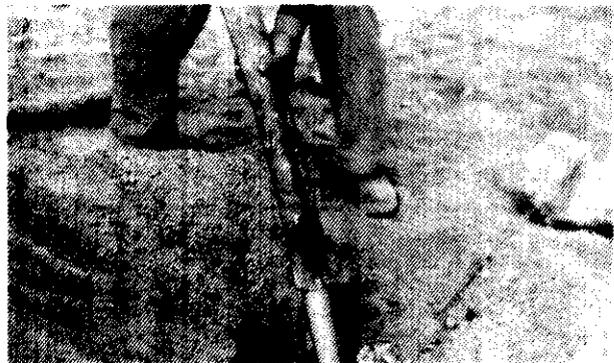
Carga de barreno con explosivo líquido: algunas protecciones personales.
