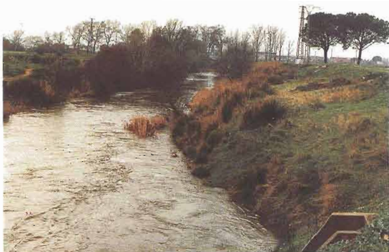
Emisario de efluentes de la Planta de tratamiento de las aguas residuales de Alcalá. La reciente entrada en funcionamiento de esta planta ha supuesto un importante descenso de la carga contaminante.
