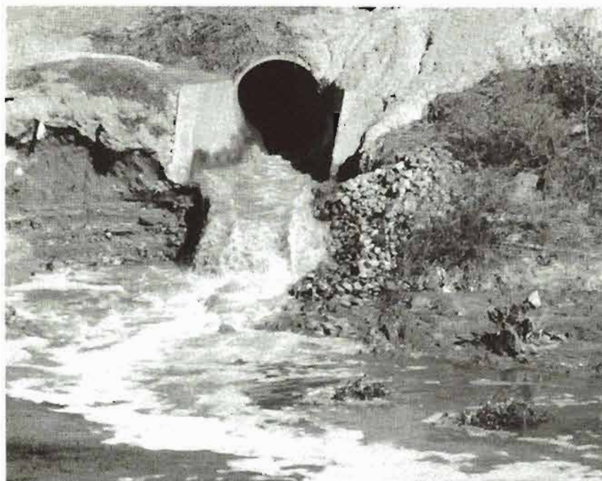
Colector de vertido de las aguas residuales de la ciudad de Guadalajara. La entrada en funcionamiento de la Planta de tratamiento (actualmente en estado de construcción), paliará en gran medida la carga contaminante de estos vertidos.
