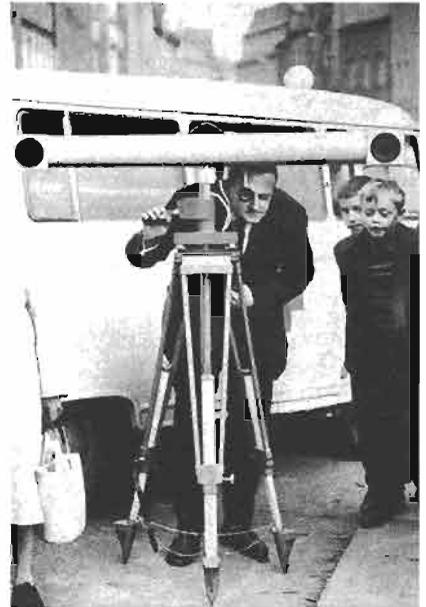
FIG. 9.—Bicámara estereométrica Carl Zeiss Jena (1956).
