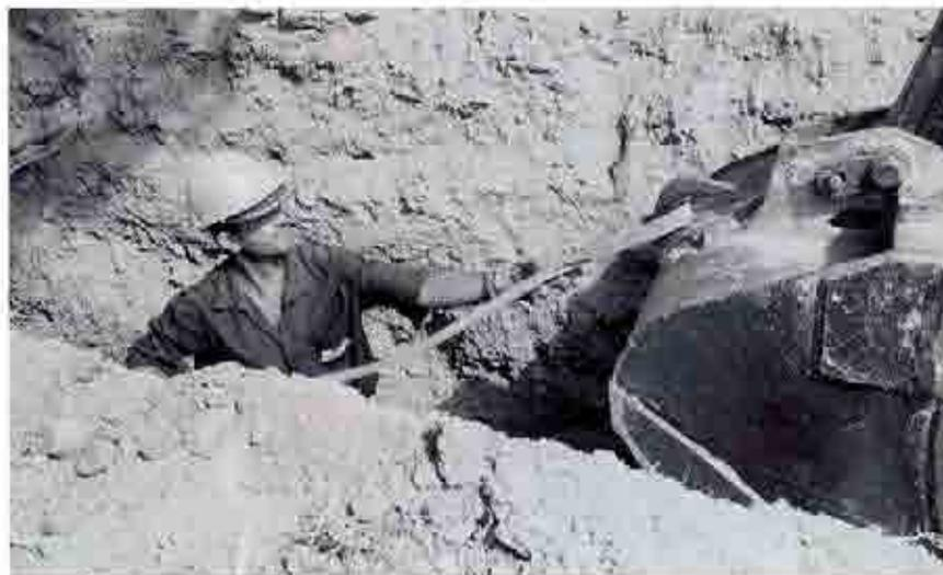
rior que forman las eslingas en el gancho supere los 90°, y sería muy recomendable auxiliarse para la colocación de los tubos del empleo de balancín.
