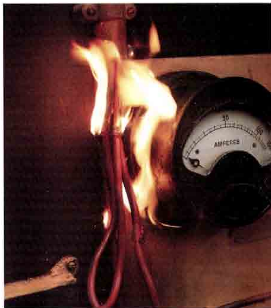
FIGURA 6. La investigación sobre los cables eléctricos es una tarea difícil, dada la «costumbre» de atribuir a la electricidad la causa de los incendios en todos aquellos siniestros en que haya involucrados equipos o conducciones eléctricos y cuyo proceso de iniciación no está claramente definido.
