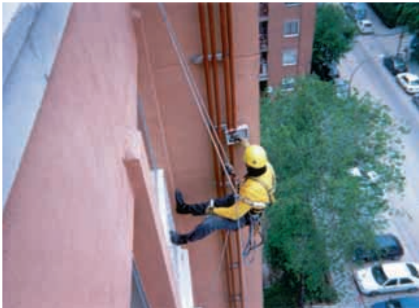
Operario en altura trabajando con sistema doble.
