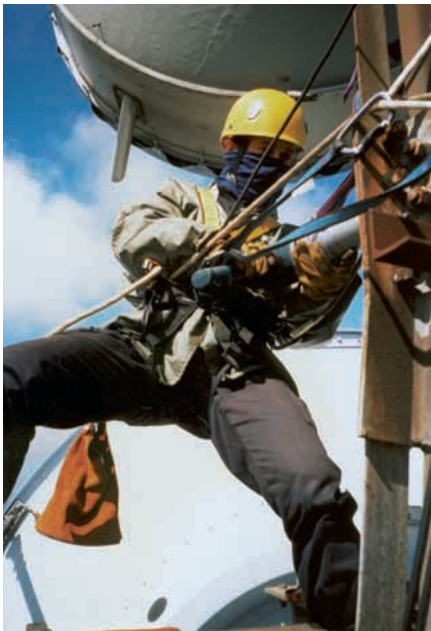
Operario trabajando sobre una estructura metálica.
