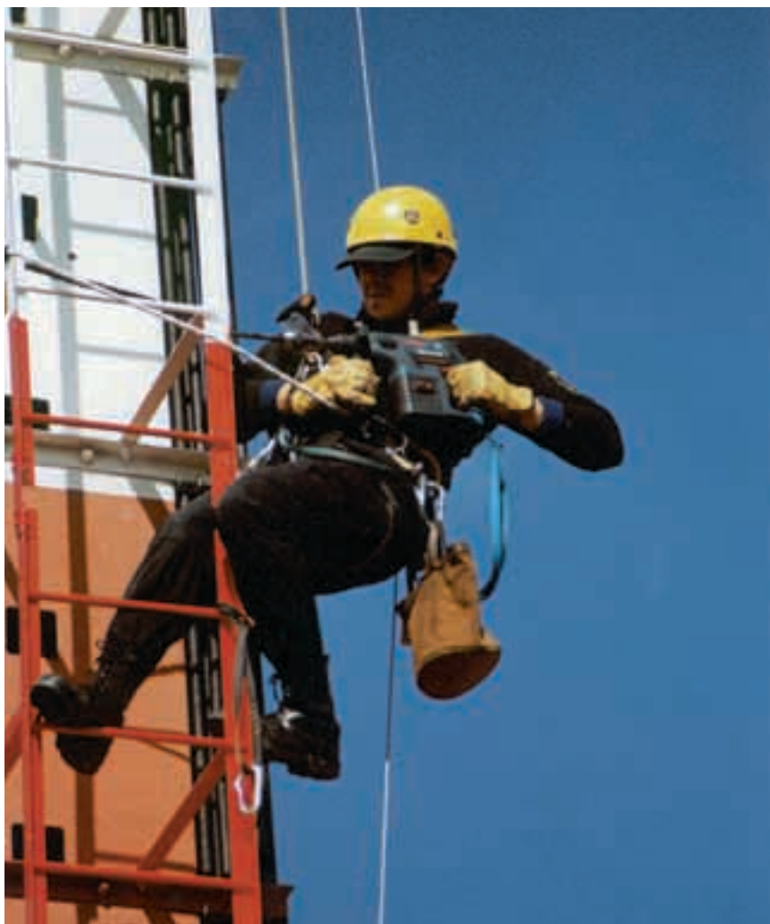
Maniobras en altura.
