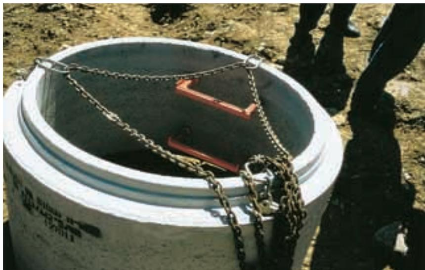
La construcción de pozos y arquetas utilizando módulos con los peldaños ya instalados eliminan los riesgos derivados de su colocación a posteriori, incluidas las posibles exposiciones a atmósferas peligrosas.
