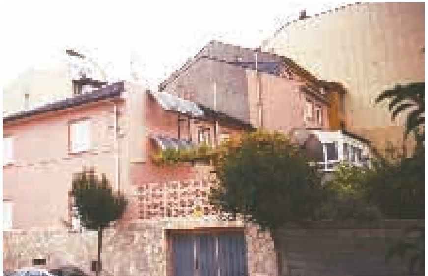
Paneles de captación de energía solar.
