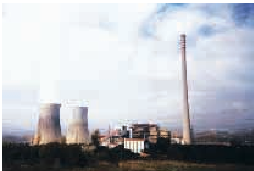
Central termoeléctrica de Compostilla en Ponferrada.
