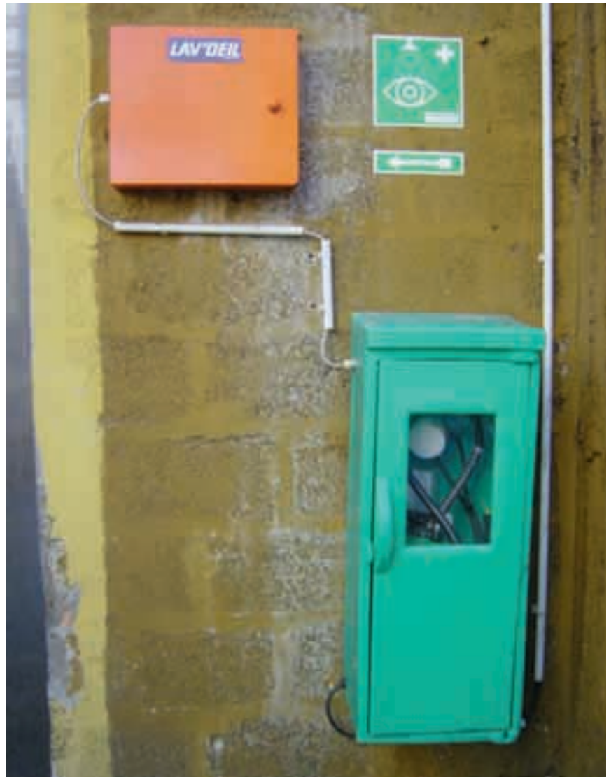
Instalación de un lavaojos ocular y de una ducha autónoma portátil de Diphoterine® en una empresa.
