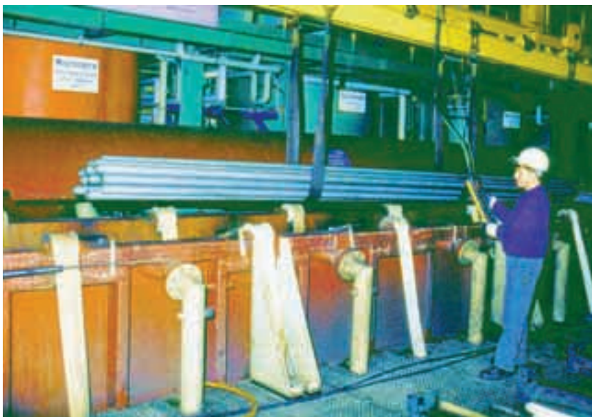
Manipulado de canalizaciones metálicas encima de un baño de decapado.
