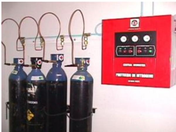
Debido a la alta presión que se encuentran los gases se utilizan reguladores de presión o manorreductores que reducen la presión hasta la requerida.
