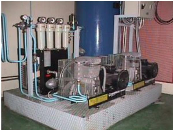
En grandes centros hospitalarios se cuenta al menos con dos compresores, uno auxiliar con arranque automático en caso de fallo del principal. En instalaciones más pequeñas se tiene un compresor con una batería de botellas de reserva.
