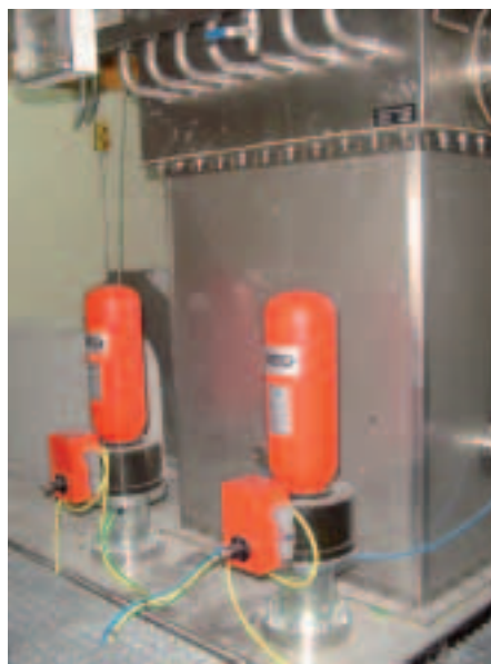
Sistema de supresión en molinera de azúcar.
