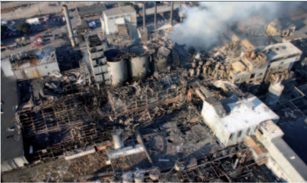
Resultados de la explosión en la fábrica de Imperial Sugar (Estados Unidos) el pasado mes de febrero.
