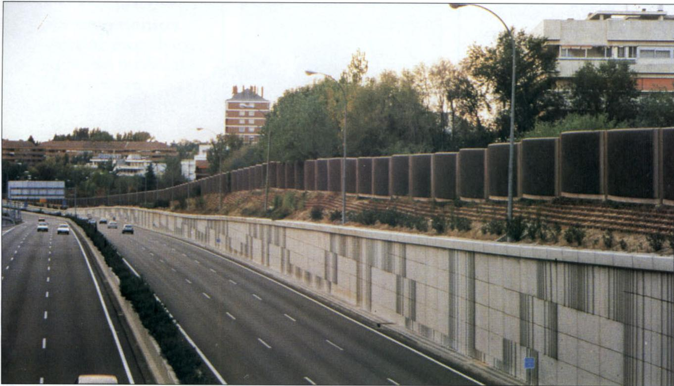
Las barreras antiruido protegen a las viviendas próximas a las grandes vías de los ruidos generados por la rodadura.
