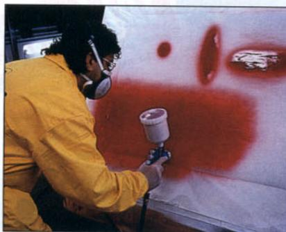
Pulverización sobre el patrón de prueba.
