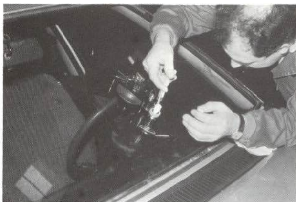
FIGURA 6 Inyección de resina en el interior del tornillo "A" mediante una jeringuilla
