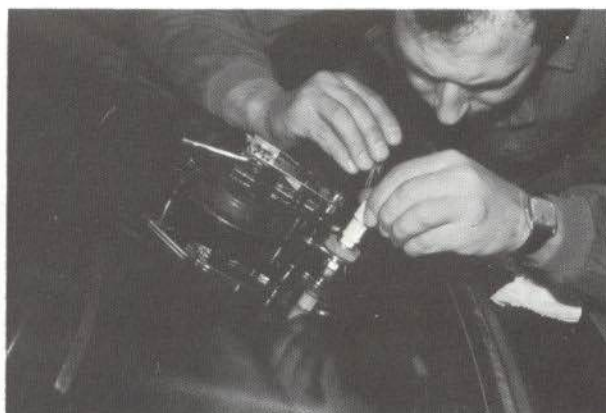
FIGURA 7 Inyección de resina mediante el roscado del tornillo interior "B"
