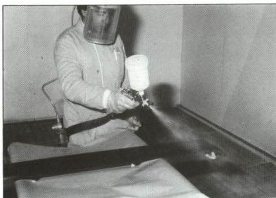
FIGURA 4.—Aplicación de imprimación
