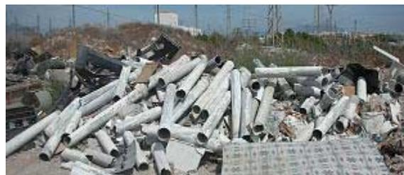
*Las tuberías que contienen amianto deben ser retiradas y depositada en un vertedero de residuos industriales.*
