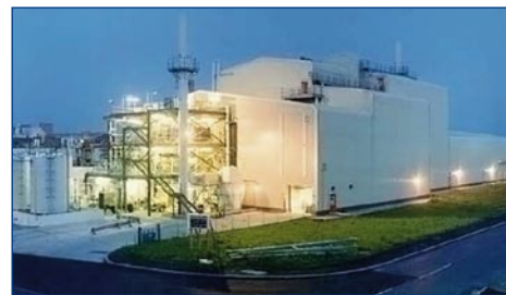
Fábrica de combustible de Springfields
