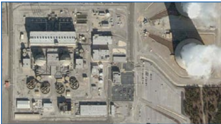
Central nuclear de Vogtle (Georgia, EEUU)
