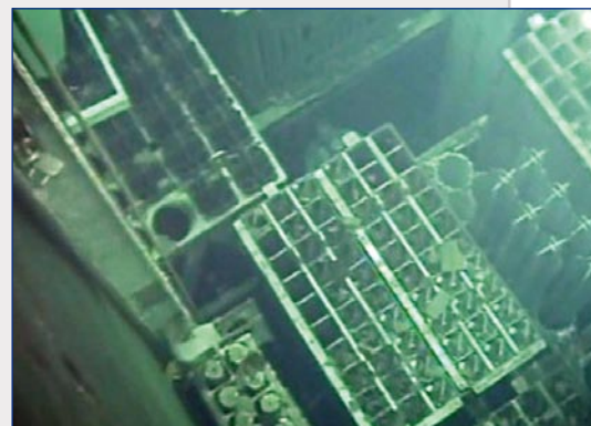
Inspección visual de la piscina de la unidad 4 (Foto: WNN)
