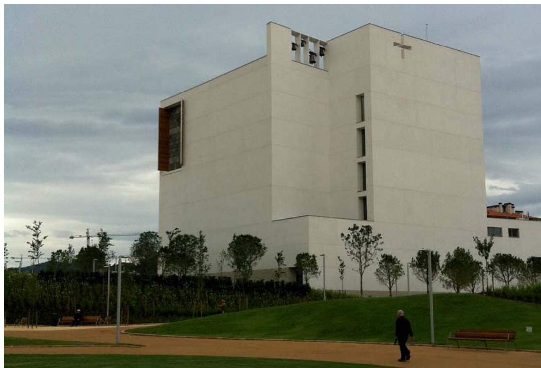
Las fachadas de la iglesia de Riberas de Loiola, en Donostia-San Sebastián, están revestidas con un mortero autolimpiante y descontaminante.
