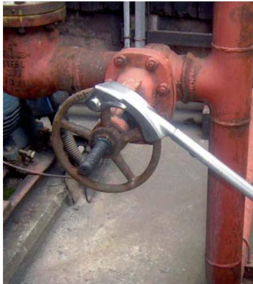
Fig.5 Llave prototipo en prueba.
