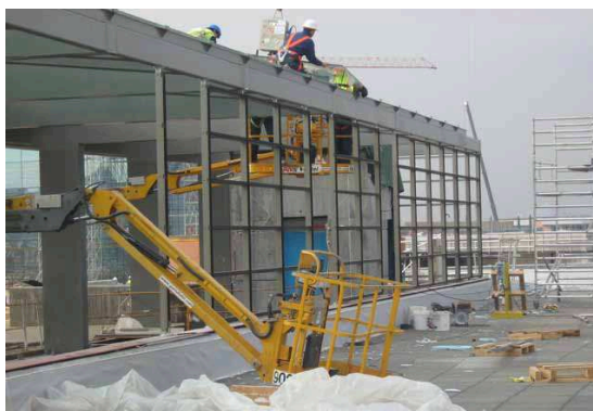
Ilustración 4. Instalación de cubierta acristalada.
