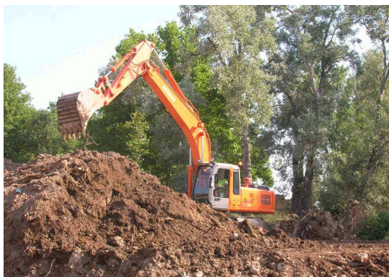
Ilustración 11. Movimiento de tierras mediante retroexcavadora.
