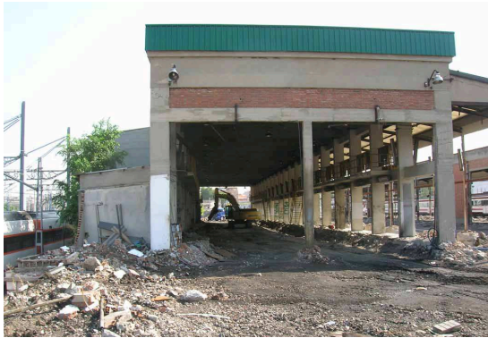
Ilustración 8. Demolición de edificio.
