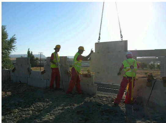
Ilustración 3. Instalación de paneles de tierra armada.
