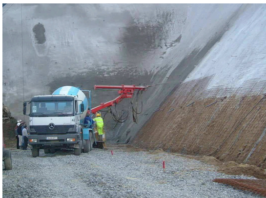
Ilustración 10. Gunitado de talud.
