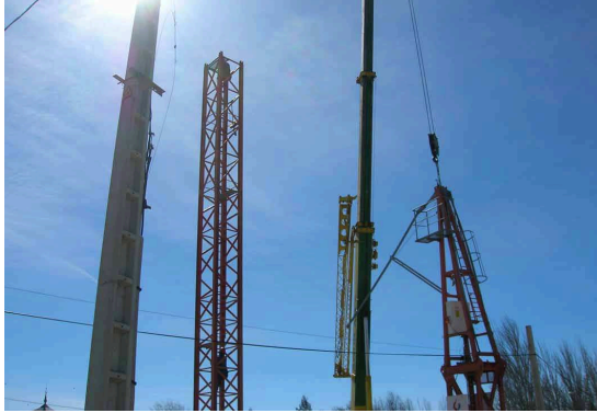
Ilustración 2. Montaje de grúa en obra de construcción.
