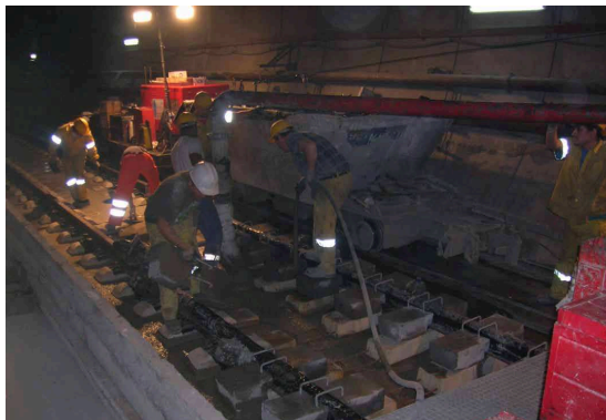
Ilustración 1. Hormigonado en vía ferroviaria.
