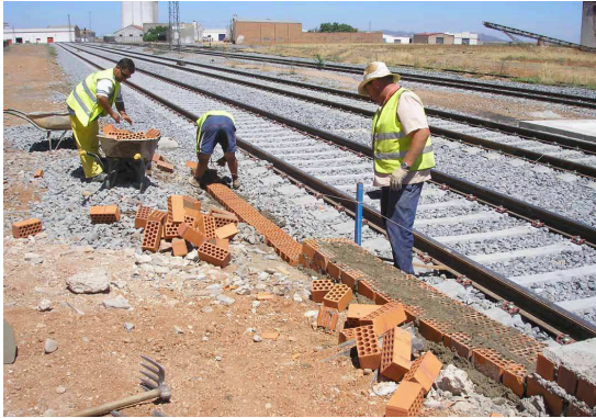
Ilustración 5. Trabajos de albañilería en vía ferroviaria.
