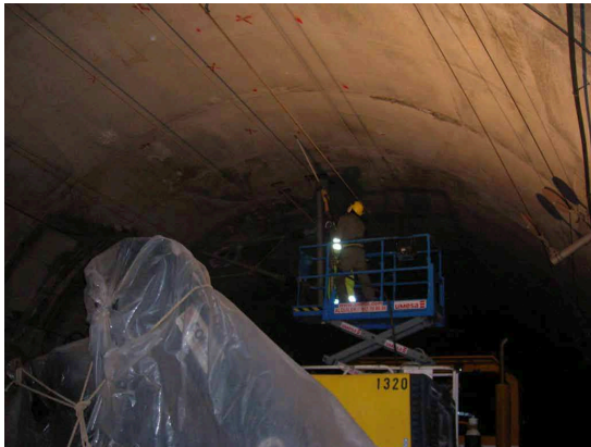
Ilustración 7. Grupo electrógeno con motor diésel en túnel.
