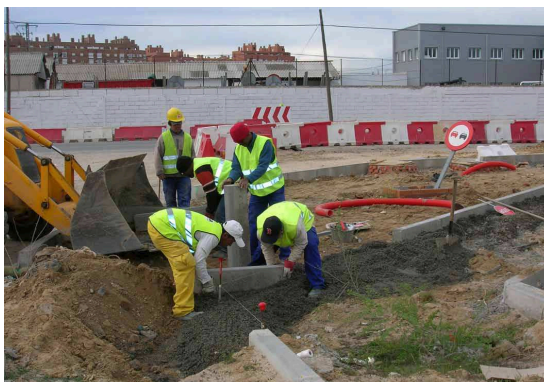
Ilustración 2. Postura forzada durante la instalación de bordillo.
