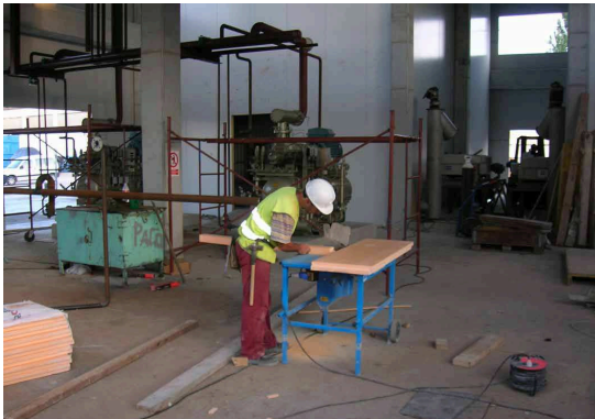
Ilustración 8. Corte de madera mediante sierra circular.
