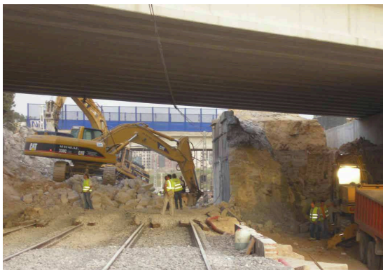
Ilustración 6. Trabajadores expuestos a humo de escape de retroexcavadoras.
