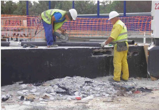
Ilustración 6. Corte de tubo mediante sierra circular.
