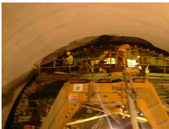
Ilustración 2. Trabajos de revestimiento de túnel.
