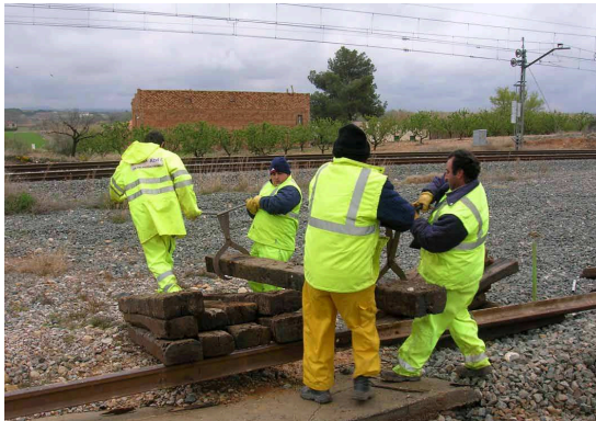
Ilustración 7. Manipulación de traviesa mediante pinzas manuales.
