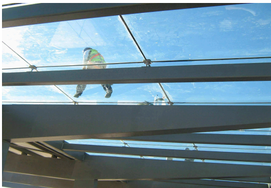
Ilustración 3. Tránsito por cubierta acristalada.
