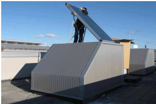
Ilustración 5. Instalación de panel solar en cubiertas.
