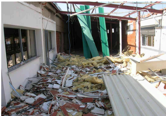
Ilustración 2. Residuos de demolición.
