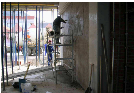
Ilustración 4. Enyesado de tabique.
