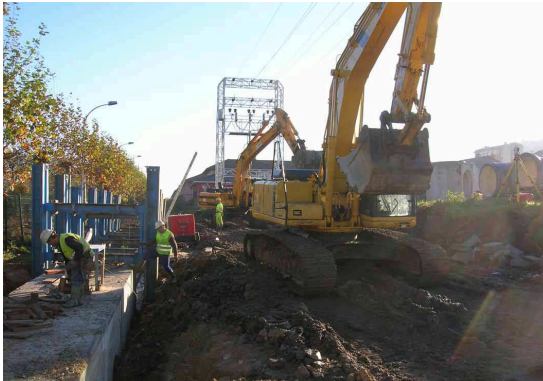
Ilustración 4. Trabajadores en las inmediaciones de maquinaria de movimiento de tierra.
