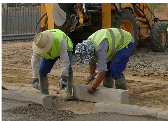
Ilustración 1. Instalación de bordillos de hormigón.
