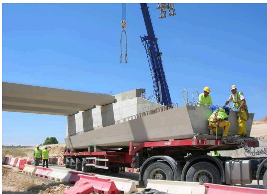
Ilustración 6. Preparación de izado de viga prefabricada para puente.
