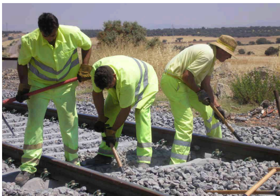
Ilustración 8. Manejo de herramientas manuales en obra de mantenimiento de vía ferroviaria.
