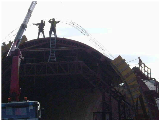
Ilustración 1. Instalación de estructura en construcción de falso túnel.
