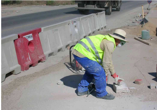
Ilustración 4. Corte de bloques de hormigón mediante sierra circular.
