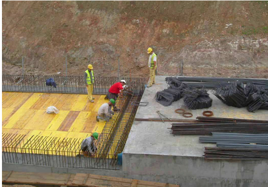
Ilustración 7. Instalación de estructura previa al hormigonado.
