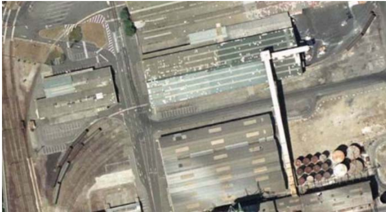
Figura 6: Vista aérea de la planta de AZF antes del siniestro.
