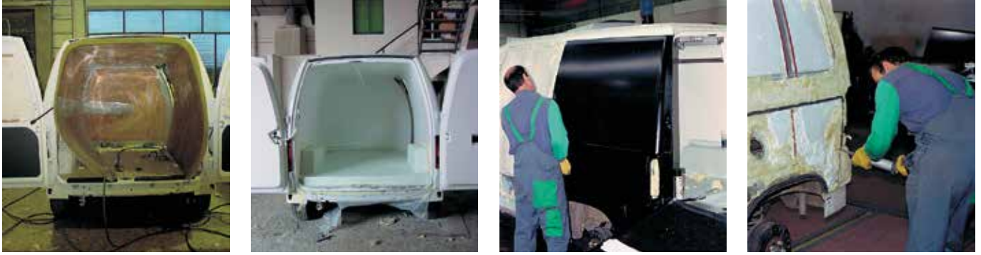
► Procesos de construcción y reparación
