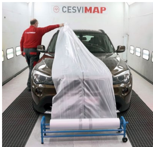
► Plástico especial para el enmascarado del vehículo
