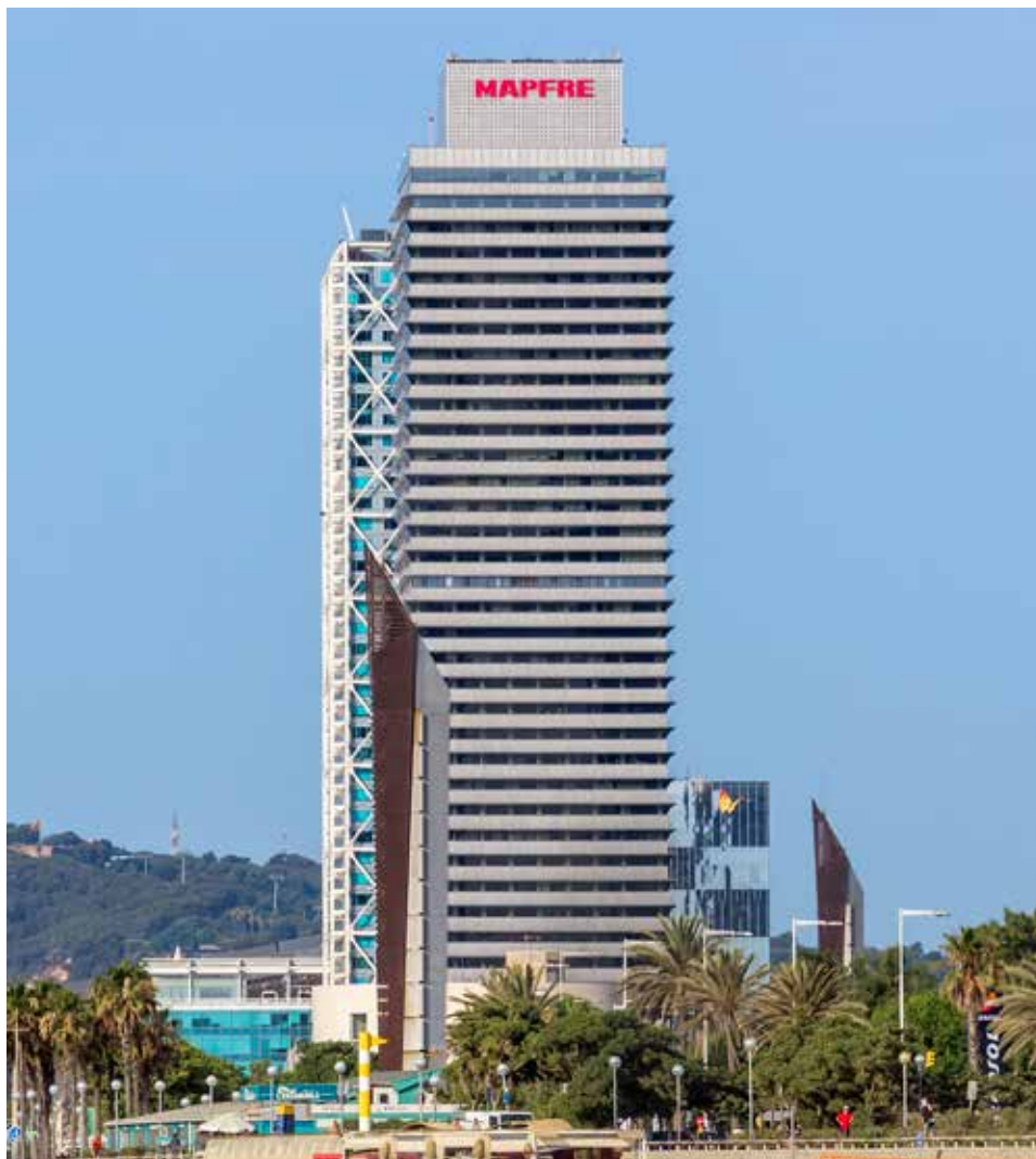
Torre olímpica MAPFRE em Barcelona
