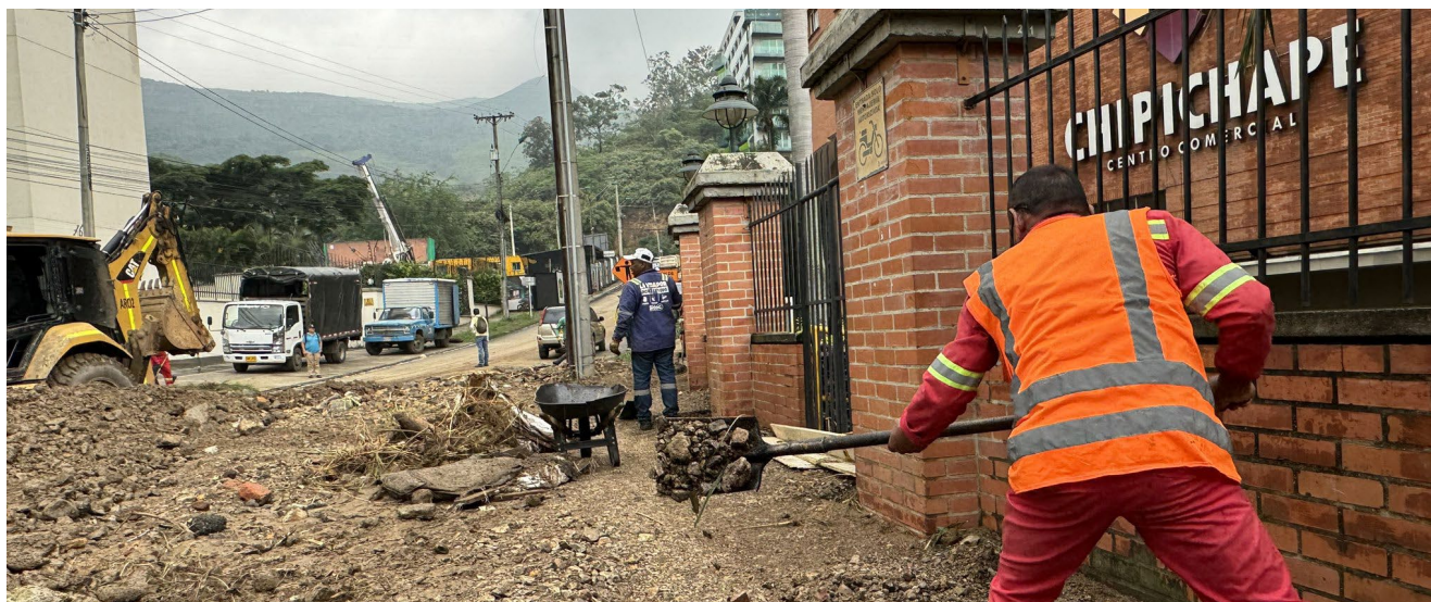
Foto tomada de: @Infraescali / X
