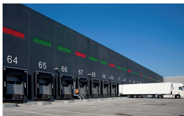
Imagen 2. Muelles de carga/descarga y guías de posicionamiento
